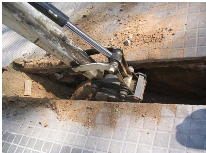
Fotografia núm. 1: Obertura de la rasa 100
